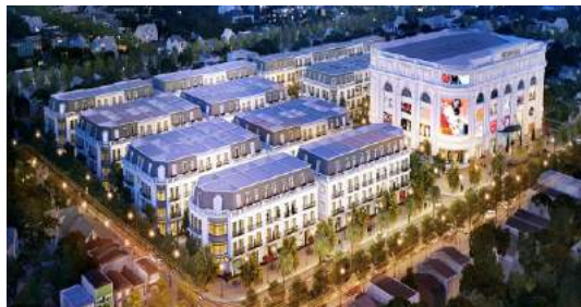
Vincom Vinh Long - TP Vinh Long
